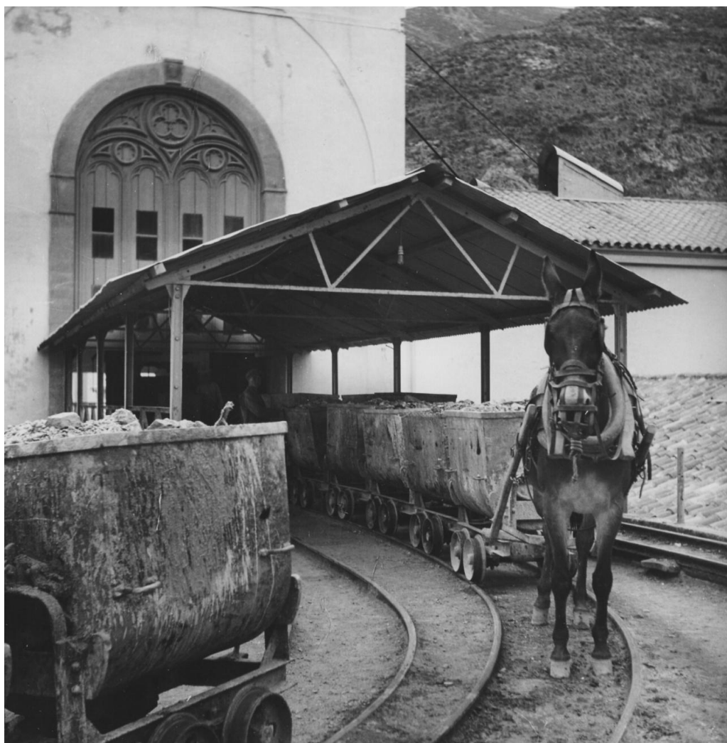
Miniera di Montevocchio. Il Pozzo di Sant'Antonio nei Cantieri di Levante in una immagine degli anni Trenta del secolo scorso. Il traino dei carrelli avveniva con l'ausilio di quadrupedi - Foto Parco Geominerario Storico Ambientale della Sardegna
