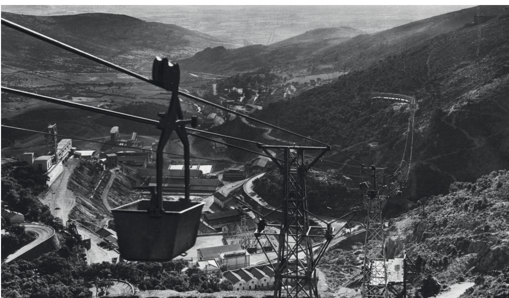
Miniera di Montevecchio. Seconda metà degli anni 50 del secolo scorso - Panoramica dei Cantieri di Levante - Sulla sinistra il Pozzo Sartori - Foto Parco Geominerario Storico Ambientale della Sardegna
